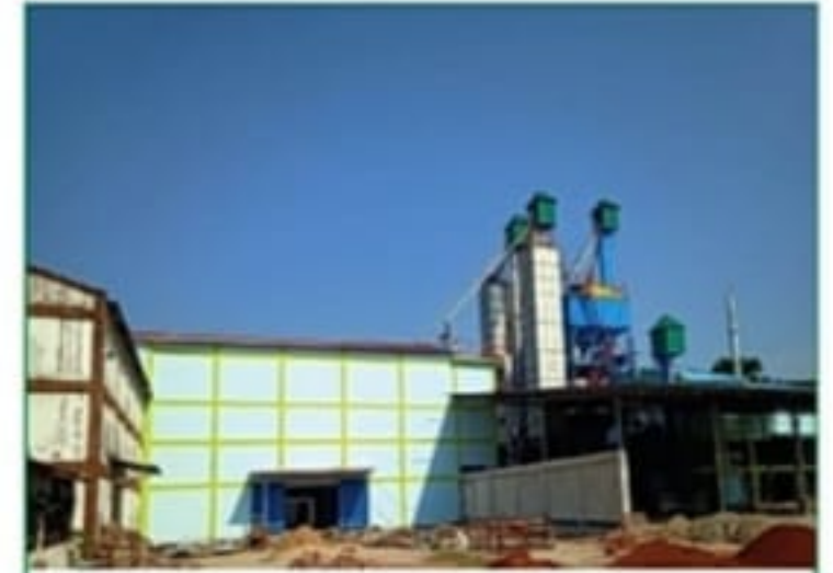
শাকিল অটো রাইস মিল, হালুয়াঘাট, ময়মনসিংহ। প্রতিদিন ৯৬ টন ক্ষমতাসম্পন্ন পারবেয়েলিং, ড্রায়ার, ৪ টন বয়লার এবং ৮ টন মিলিং।
